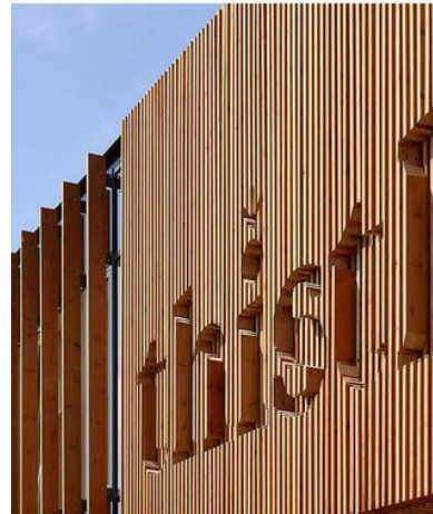
Hout en bedrijfsnaam verwerkt in de gevel
